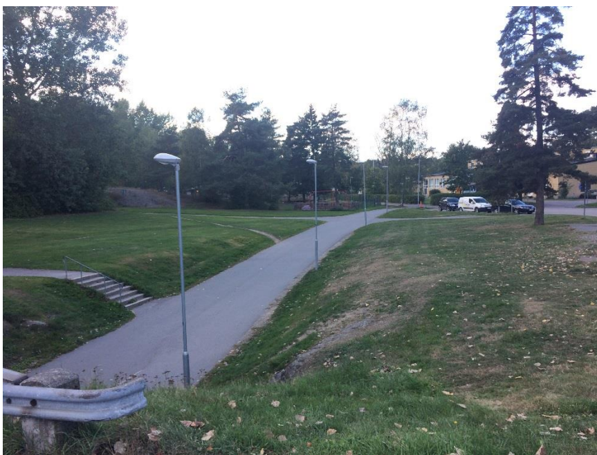
Figur 17. Utblick mot den västra nedfarten till gångtunneln.
